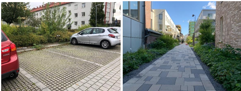
Figur 12. Exempelbilder för genomsläpplig beläggning på parkeringsytor samt gårdsyta på bjälklag (Foton: Bjerking).
