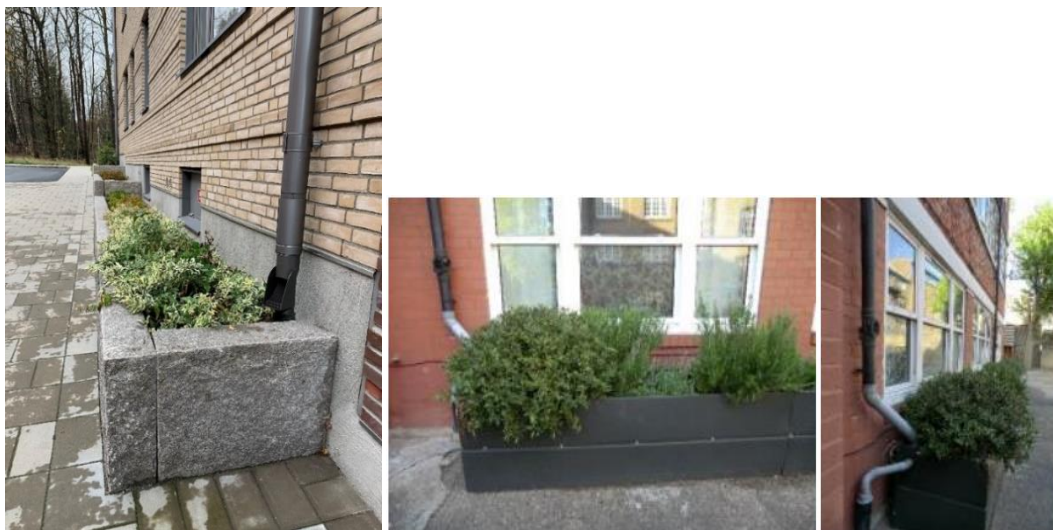
Figur 13. Exempel på regnväxtbädd intill fasad samt omledning av stuprör till växtbädd. (Foto: t.v. Bjerking, t.h. Sweco).
