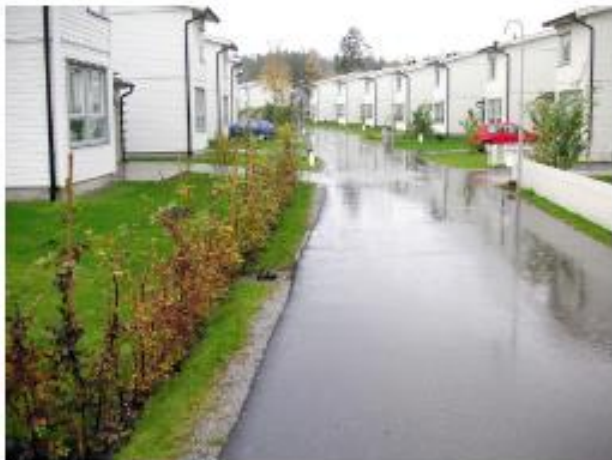
Figur 14. Exempel på makadamdike längs väg. Foto: WRS.
