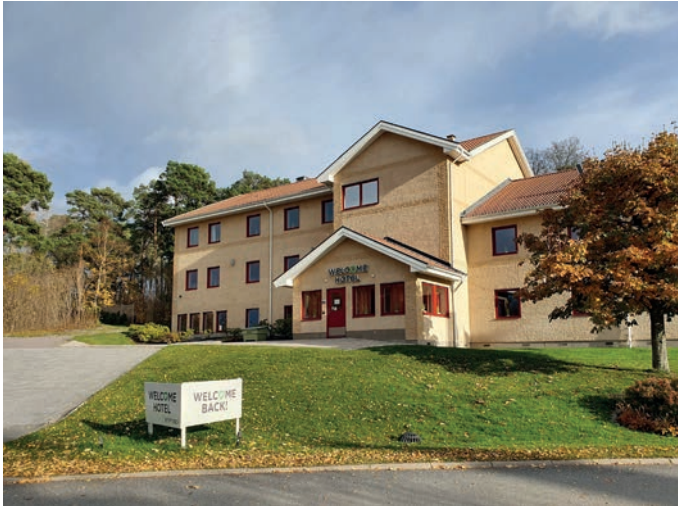
Welcome Hotel framträder med sin placering på hörntomten som fond för siktstråk från flera gatuvyer och bildar entré till området från väster.
