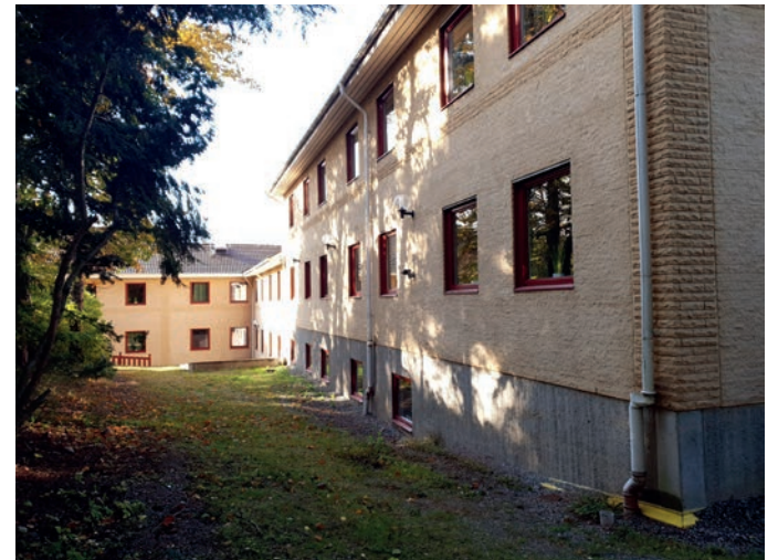
En ambition att anpassa byggnadskomplexet till den naturliga topografin och den omgivande miljön märks genom bebyggelsens placering i souterräng och dess uppbrutna, förskjutna volymer som ger en variation i taksiluett och fasaduttryck.
