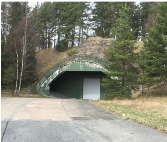
Västra entrén till bergrummet
