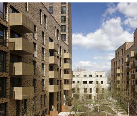
Balkonger mot gård
