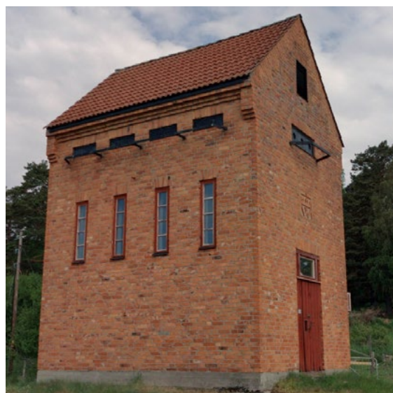
Närbild av transformatorstationen
