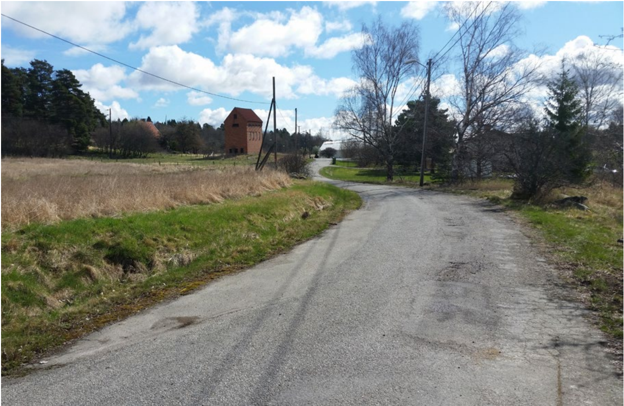
Ormbäckavägen med transformatorstationen, i bakgrunden skymtas torp och växthus
