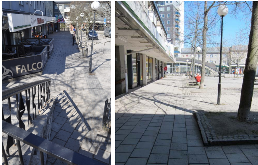
Bild 31 Fotografier från Blackebergsgatan före ombyggnad.
