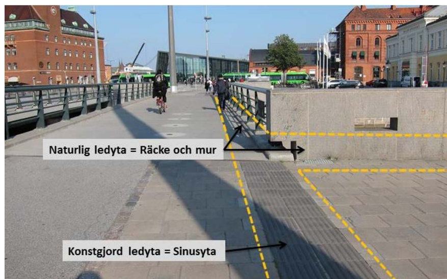
Bild 3 Sinusytan (den konstgjorda ledytan) tillsammans med räcket och muren (naturliga ledytor) illustrerar en del i ett ledstråk.
