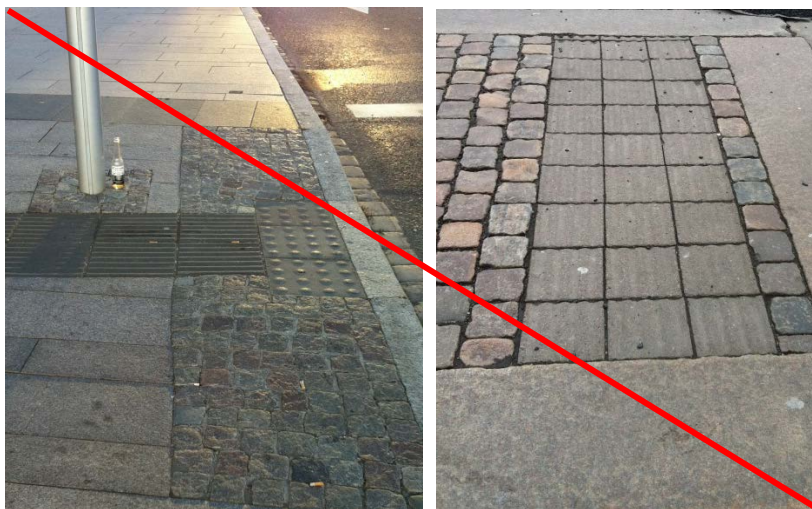
Bild 18 Den taktila upptäckbarheten förstörs om en taktil yta läggs tillsammans med smågatsten.
