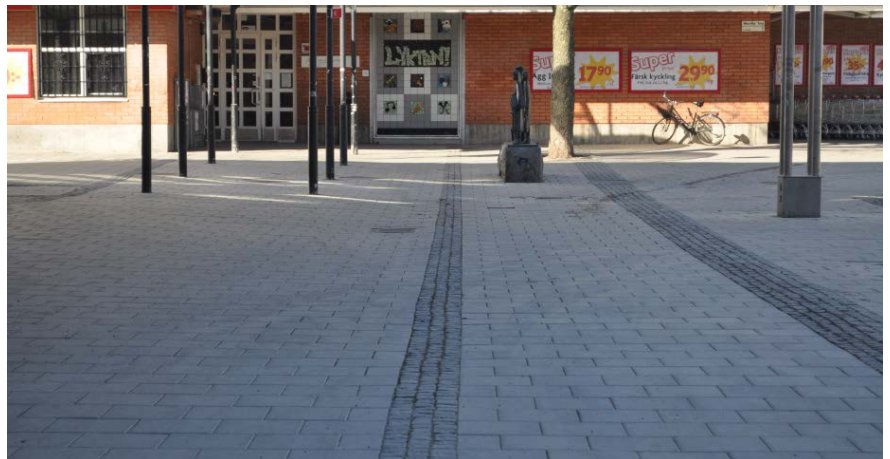
Bild 33 Fotografiet är taget innan ombyggnad av ledytan mot ICA i punkt 1, angivet i flygbild och på planritning nedan.
