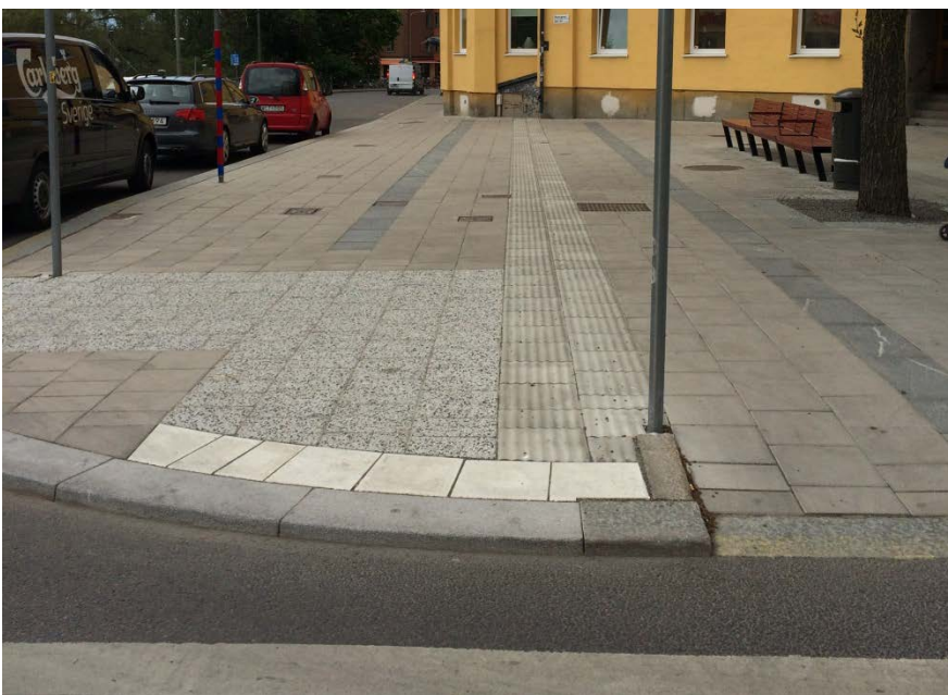
Bild 25 Den konstgjorda ledytan ska gå fram till den vita plattraden.
