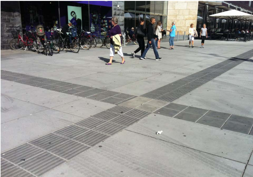
Bild 6 En slät valyta, i korsningsytan mellan ledytorna.
