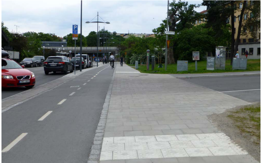
Bild 26 Varningsytor vid genomgående gångbana.
