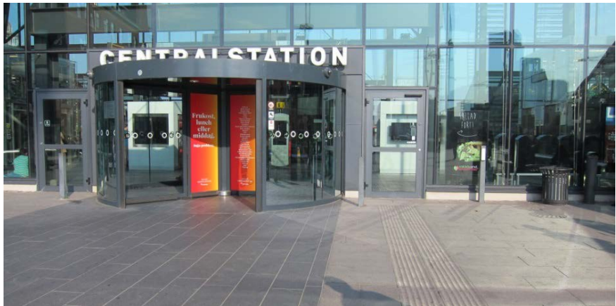
Bild 27 Entré med karuselldörr där ledstråket går till en vanlig dörr. Ledytan borde dock leda till manöverdonet (Manöverdon är felplacerat).
