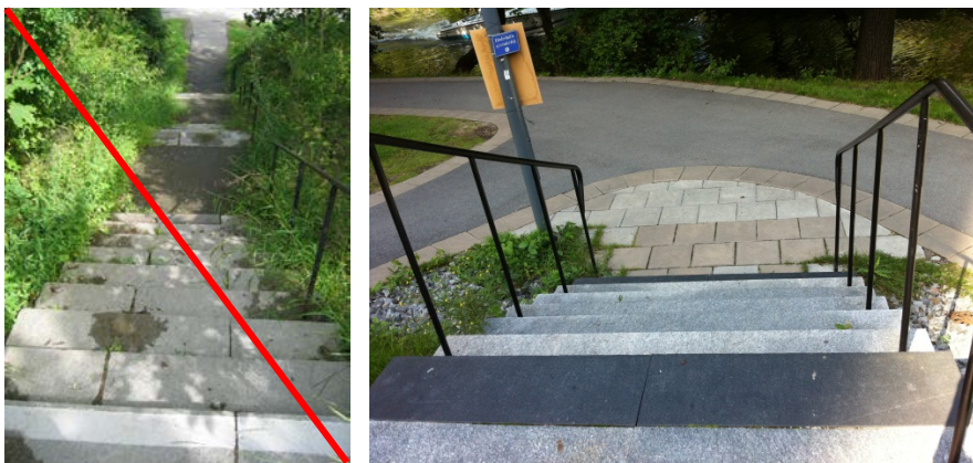
Bild 31 På bilden till höger kan räcket användas för ledning men inte i trappan på bilden till vänster.
