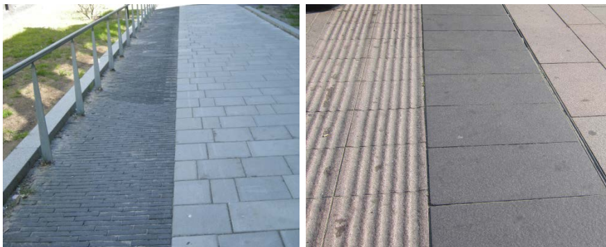
Bild 20 En tydlig ljushetskontrast skapas mellan materialen. Kontrasten ger riktningshjälp. Taktill ledning kan fås genom räcket, bild till vänster.
