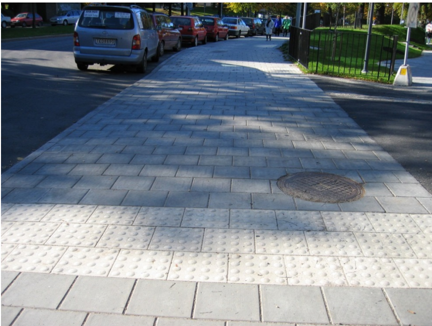
Bild 16 Exempel på taktila varningsytor i form av kupolplattor. På övre bilden saknas ledning fram till kupolplattorna.
