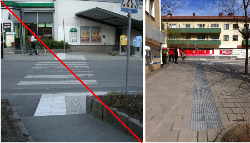
Bild 12 Den naturliga ledytan (muren) på den vänstra bilden är inte sammanhängande med den konstgjorda ledytan (sinusplattan). På bilden till höger är den naturliga ledytan i form av kanten på planteringen sammankopplad med den konstgjorda ledytan.
