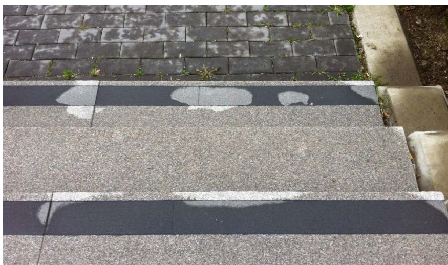
Bild 8 En kontrastmarkerad trappa med torra och våta partier.
