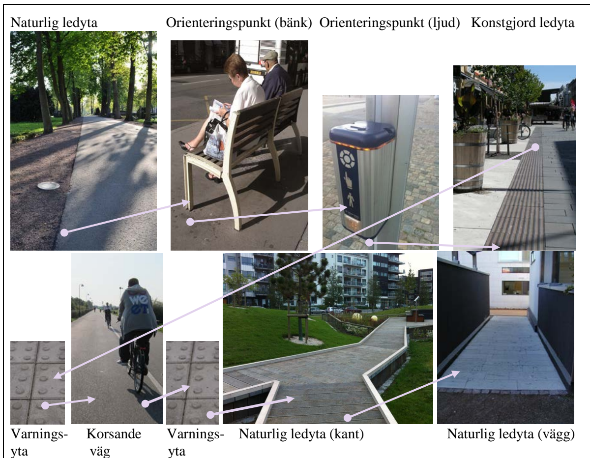
Bild 9 Exempel på en kedja av naturliga- och konstgjorda ledytor, varningsytor och orienteringspunkter som tillsammans bildar ett ledstråk. De grå pilarna pekar i tur och ordning på de olika elementen som tillsammans bildar ett sammanhängande ledstråk.
