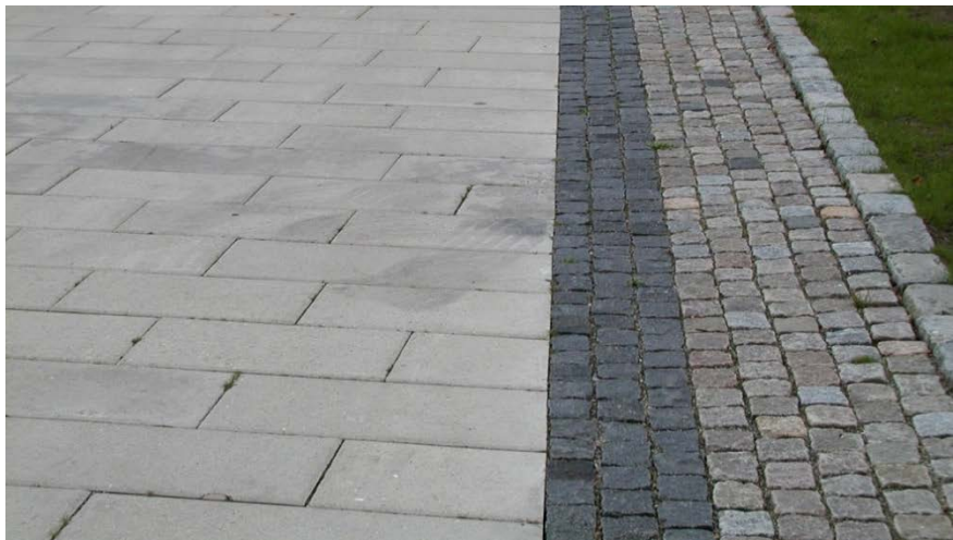
Bild 7 Ljushetskontrasten mellan betongplattorna och den mörka smågatstensranden är 0,44 (Betongplatta v=0,64 , Mörk smågatsten v=0,20 ).
