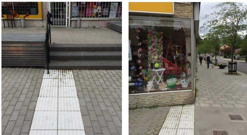
Bild 28 Ledytor som ansluter till räcke och fasad.
