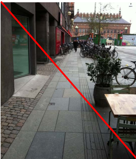
Bild 13 Hinder är placerade för nära ledytan som dessutom är smal. Ljushetskontrast saknas.
