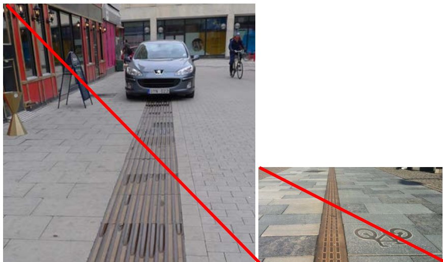
Bild 11 Ledstråk är placerat som en separering, vilket inte ger en säker yta.
