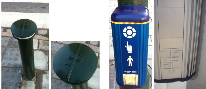
Bild 23 Taktill information på en pollare respektive tryckknappslåda.
