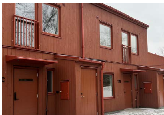
Exempel på fasad i trä med en tydlig skarv (Nordblick, 2022).
