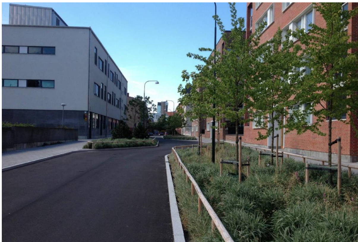
Figur 5-2. Regnbädd intill gata. Källa: Rent dagvatten academy.
