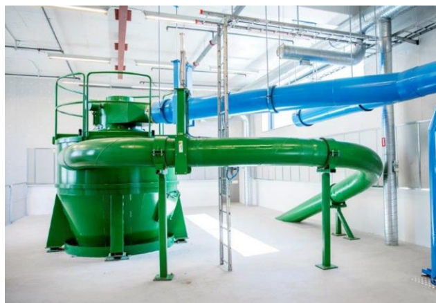
Bilder på Terminal A i Barkarbystaden tagna inifrån. Bilden till vänster visar sopsugsledningar som ansluter till containrar med olika avfallsfraktioner, medan bilden till höger visar sopsugsledningar som ansluter restavfallsfraktionen till en komprimator, en så kallad cyklon.
