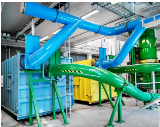
Bilder på Terminal A i Barkarbystaden tagna inifrån. Bilden till vänster visar sopsugsledningar som ansluter till containrar med olika avfallsfraktioner, medan bilden till höger visar sopsugsledningar som ansluter restavfallsfraktionen till en komprimator, en så kallad cyklon.
