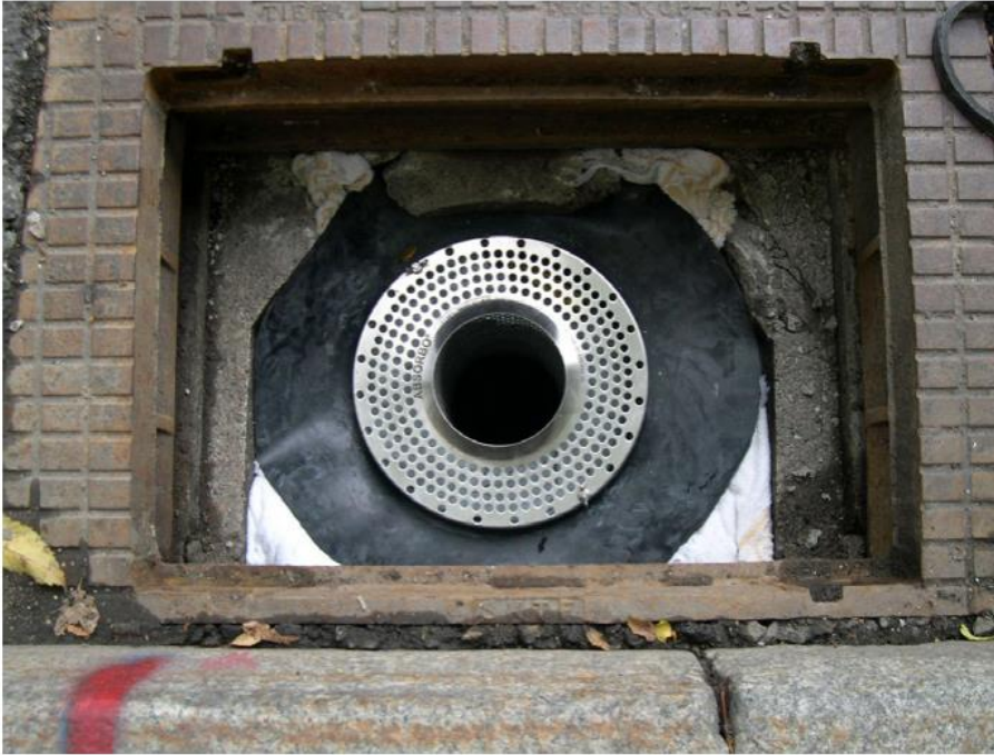
20.1 Foto av isatt filter i befintlig brunn. Bildkälla: Stockholm vatten och avfall 2021.
