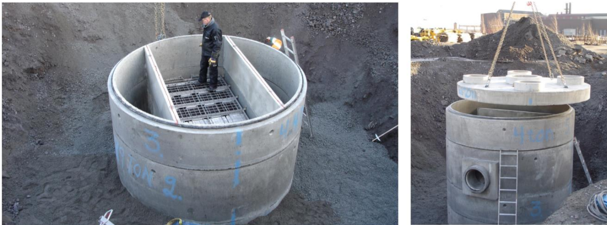
20.1 Foto av en stor lamelloljeavskiljare i betong. Bildkälla: Stockholm vatten och avfall 2021.
