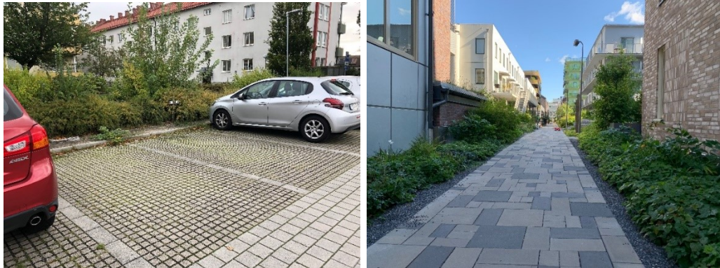
Figur 12. Exempelbilder för genomsläpplig beläggning på parkeringsytor samt gårdsyta på bjälklag (Foton: Bjerking).
