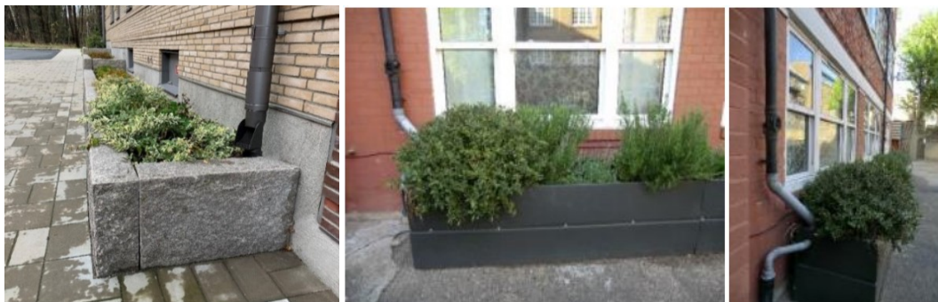
Figur 13. Exempel på regnväxtbädd intill fasad samt omledning av stuprör till växtbädd. (Foto: t.v. Bjerking, t.h. Sweco).
