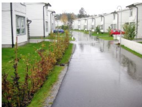
Figur 14. Exempel på makadamdike längs väg. Foto: WRS.
