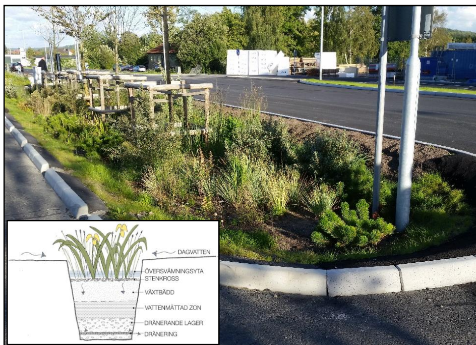
Figur 7. I den lilla figuren ses ett exempel på hur en regnbädd kan utformas. Den stora bilden avser ett kommunalt pilotprojekt i Kviberg i Göteborg. Regnbäddar föreslås på fem platser i planområdet (se bilaga 2). Foto: Norconsult.
