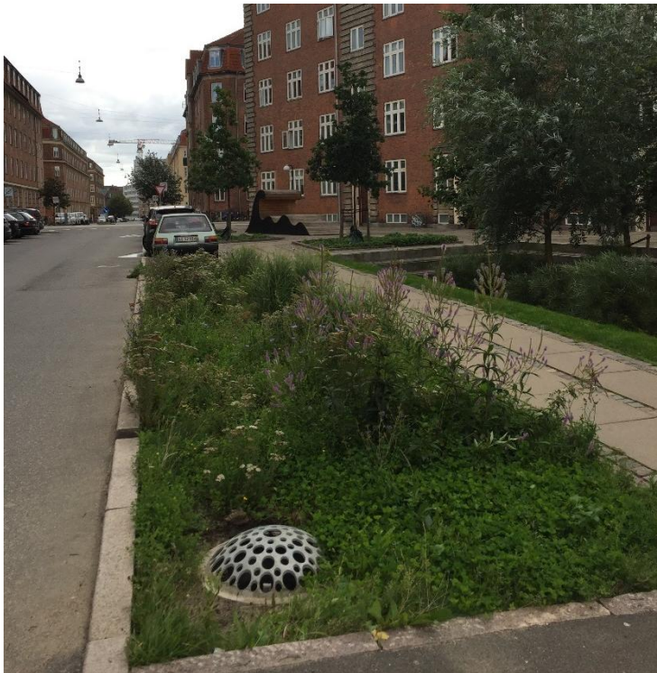
Figur 25. Exempel på växtbädd med passage för vatten i kantsten mot gata (Ramboll).
