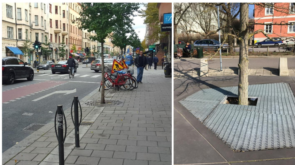
Figur 23. T.V. Exempelbild på trädgrop där vattnet avvattnas via rännor för trottoar till trädgrop och dagvattenbrunn från gata (Ramboll). T.H. Nedsänkt trädgrop med markgaller (Ramboll).
