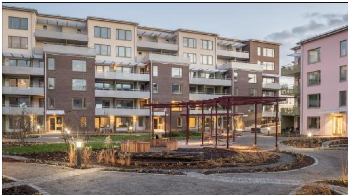
Figur 5-3. Avledning av takvatten till planteringar via rännor anlagda i gatsten. Exempelbild från Linnéhuset i Uppsala (Källa: Uppsalahem).
