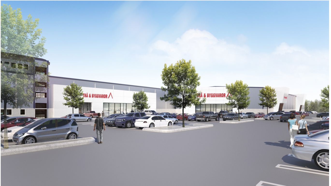
Vy mot befintlig logistikbyggnad
