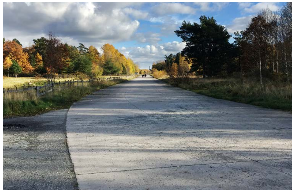
Det finns flera betongytor i området som är lämningar från den militära verksamheten 2017-10-21
